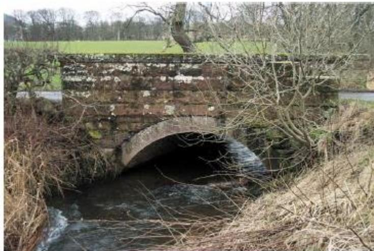
Figura 16- Il ponte è soggetto a deterioramento ed infiltrazioni causate dal fiume sottostante
