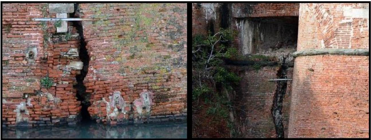
Figura 3- Monitoraggio delle crepe sulla superficie della Fortezza Vecchia, Livorno
