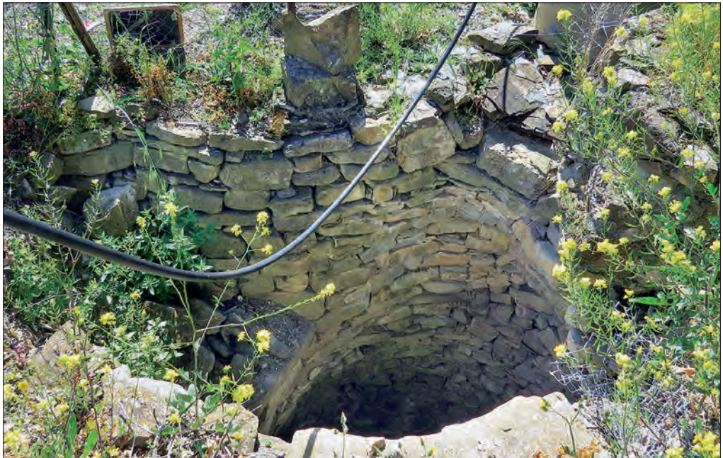
Fig. 2. - Cipressa, I Piani. Pozzo in pietra a secco con beccuccio svasato in direzione dei campi da irrigare (a sinistra) posto immediatamente ad est del lavatoio/cisterna di fig. 1.
