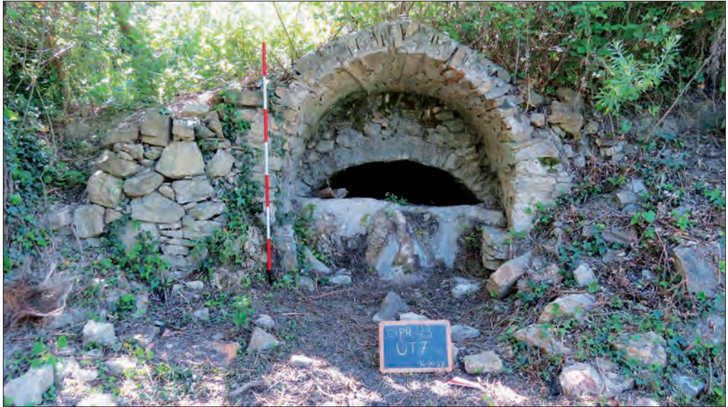
Fig. 4. - Cipressa, Viale del Posso. Cisterna con apertura voltata situata nel versante ai piedi dell'abitato di Cipressa, che potrebbe essere stata utilizzata in passato come fontana/abbeveratoio per animali
