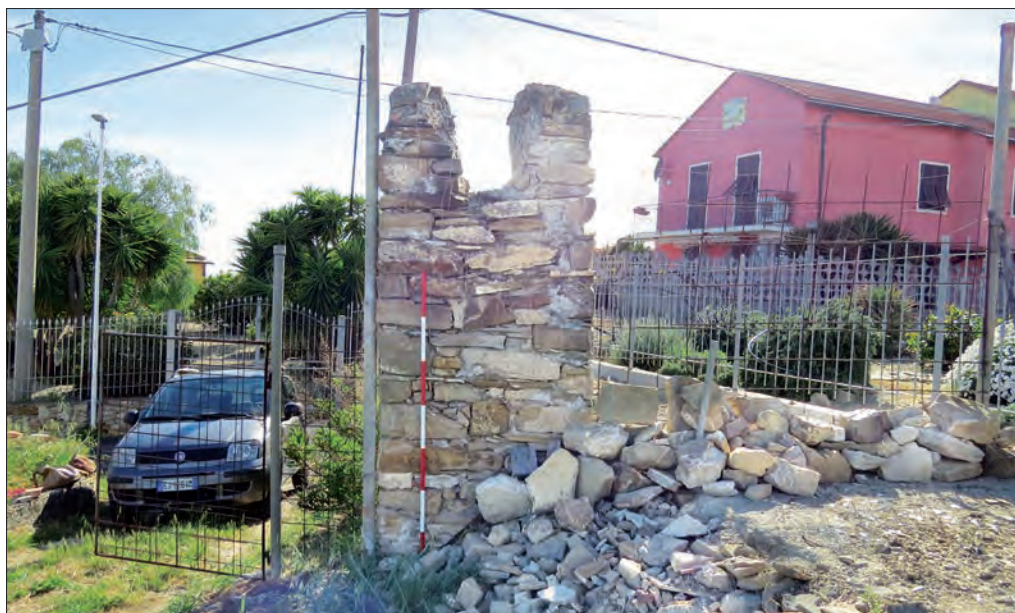
Fig. 3. - Cipressa, I Piani. Pilastro in pietra e malta pertinente un pozzo a cicogna, di cui nello specifico costituisce il fulcro per il pescaggio dal pozzo (situato originariamente nel punto di ripresa della foto).
