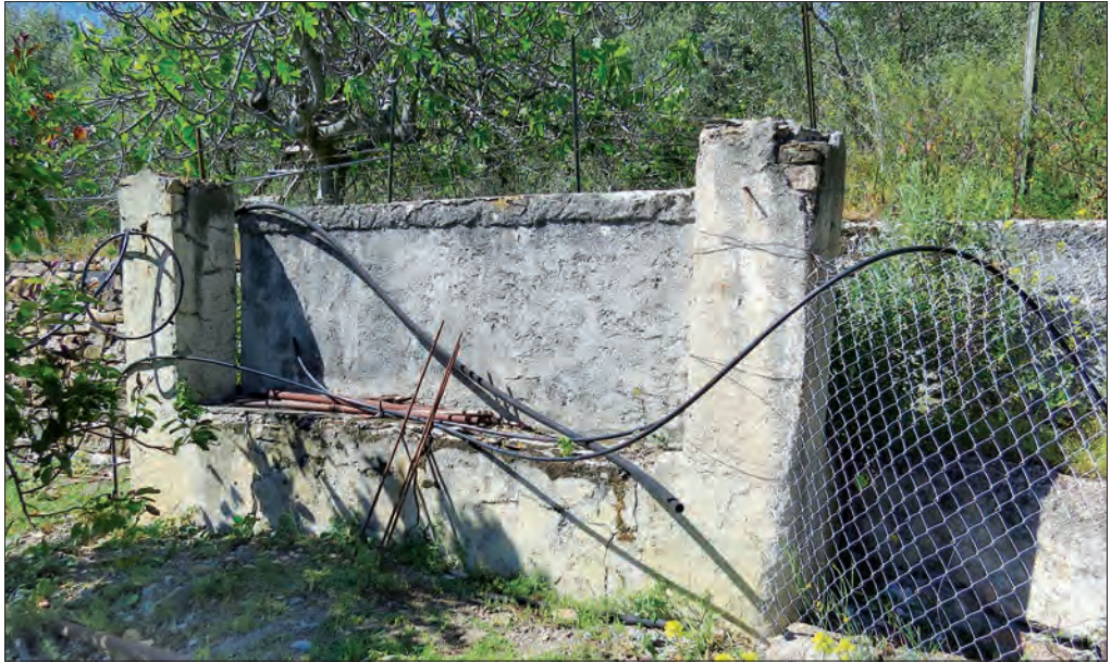
Fig. 1. Cipressa, I Piani. Cisterna quadrangolare in cemento novecentesca ricavata riutilizzando un lavatoio di una fase precedente, presso il margine superiore della fascia terrazzata a ridosso del muro a succo sommitale.
