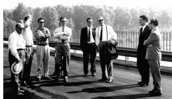
Figura 2. Il ponte di Boscotosca (PC) in costruzione (a sinistra) e il collaudo il 31 luglio 1967 (a destra): il giovane Raffaello Bartelletti è al centro insieme al suo maestro, Letterio Donato.
