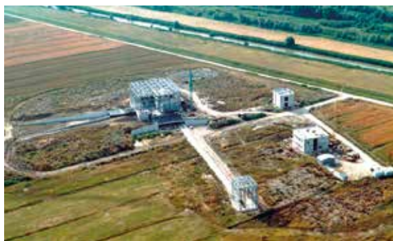
Figura 19. Complesso VIRGO (PI). Edifici in costruzione.
