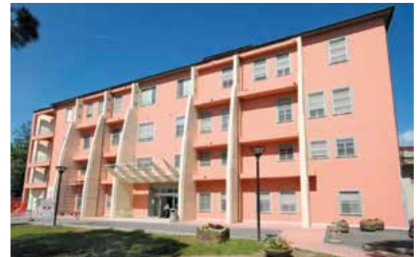
Figura 22. Ospedale di Barga. Contrafforti antisismici che caratterizzano l'intervento di adeguamento.
