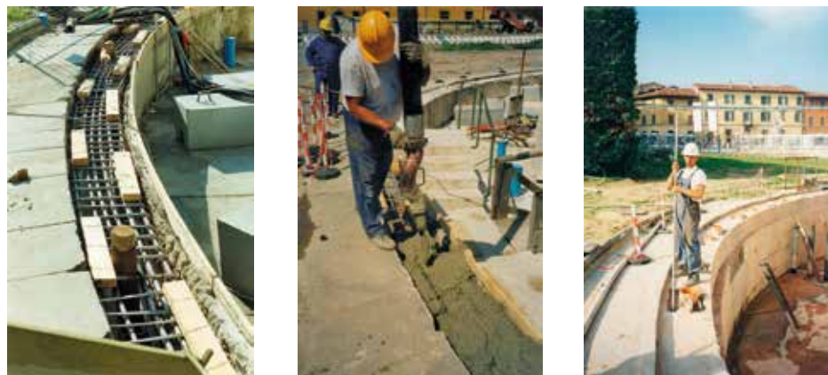
Figura 29. Lavori di stabilizzazione della Torre di Pisa. Alcuni dettagli tratti dagli elaborati grafici del progetto esecutivo di rinforzo del Catino (in alto); Immagini relative alla realizzazione della trave anulare di coronamento del Catino (in basso). Da sinistra: posa dell’armatura e dei casseri; getto del conglomerato; inserimento delle barre di cucitura.
