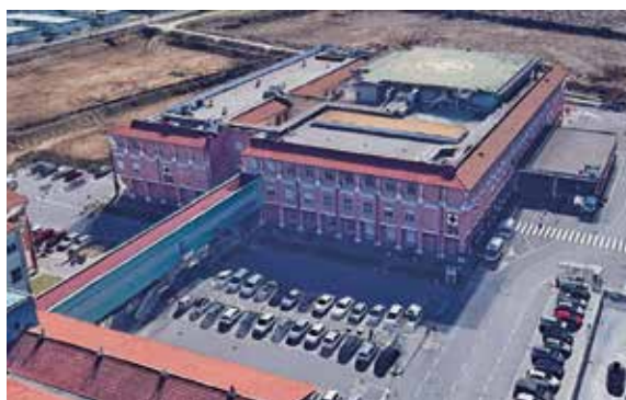
Figura 14. Il nuovo Pronto Soccorso di Cisanello (PI) prima dell'inizio dei lavori di costruzione del Nuovo Santa Chiara.
