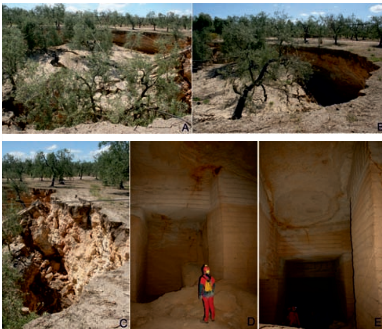
Fig. 8 - Sprofondamento del 3 Maggio 2010 a Barletta (evento n. 59 in tabella 1). A, B) vista generale dello sprofondamento; C) margine occidentale dello sprofondamento; D, E) esempi di distacchi dalla volta nella cava sotterranea di calcarenite all'origine dello sprofondamento.
