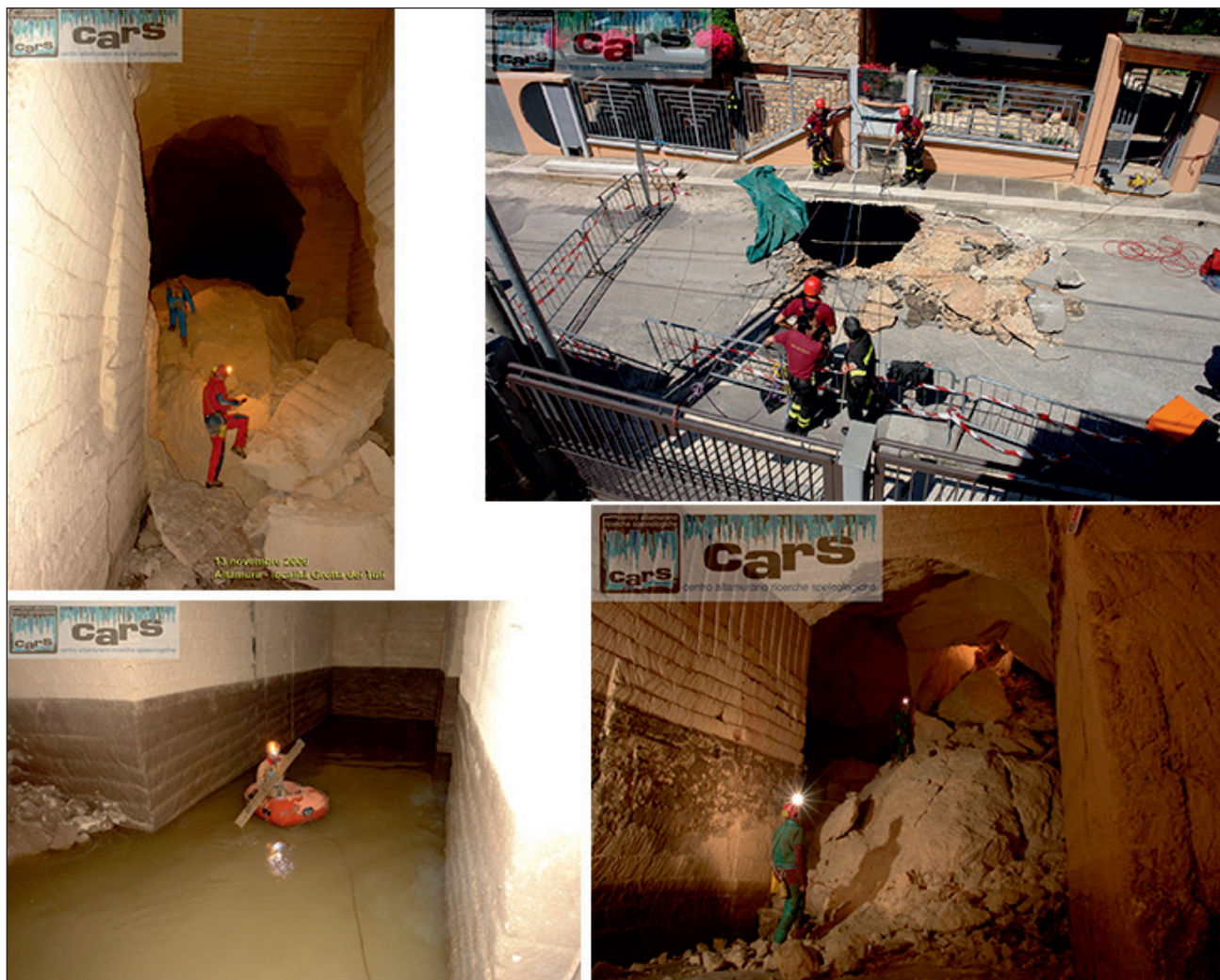
Fig. 9 - Immagini di eventi di sprofondamento ad Altamura, e evidenze dei dissesti e degli ambienti allagati nelle cave sotterranee (fotografie del Centro Altamurano Ricerche Speleologiche).
