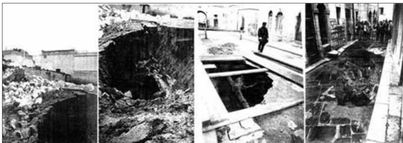
Fig. 1 - Eventi di sprofondamento nell'area urbana di Andria (foto dei primi anni '70; fonte: Progetto "Attività di ricognizione e reperimento dati sui dissesti legati alla presenza di cavità nel sottosuolo in Puglia e Basilicata", Dipartimento della Protezione Civile, Presidenza del Consiglio dei Ministri, 2000).
