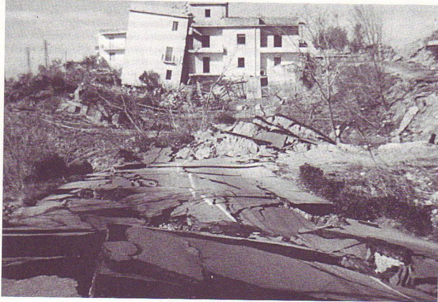
Foto 11.1. Visione panoramica della frana di «San Salvatore» di Paola (Foto: L. MERENDA, da: CATENACCI, 1992).
