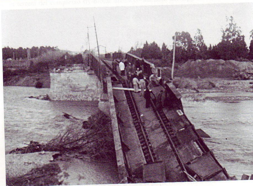
Foto 4.3. Crollo del ponte ferroviario sul fiume Alli (foto: T. MERCURI).
