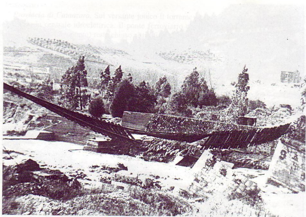
Foto 4.4. Crollo del ponte ferroviario sul fiume Corace (da: GIANGROSSI, 1973).
