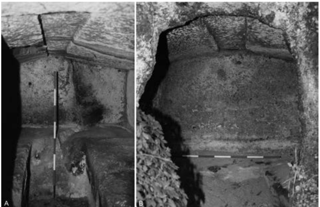
Fig. 8 - Le camere funerarie delle nn. 41 (A) e 56 (B), entrambe con soffitto displuviato e columnen incassato.
