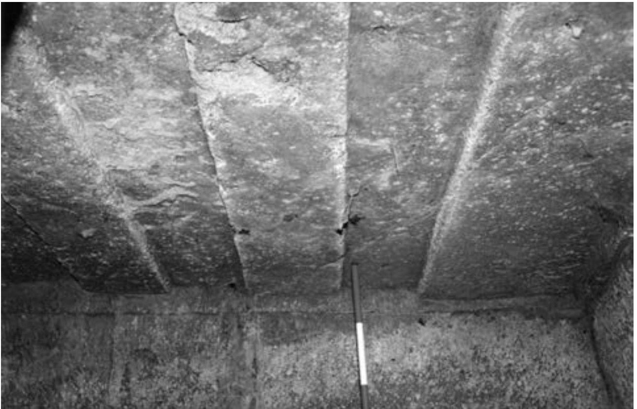
Fig. 18 - Particolare del soffitto della tomba n. 93, piano e con travi a rilievo.
