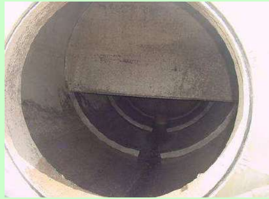
Esempio di diaframma anti-sbattimento
