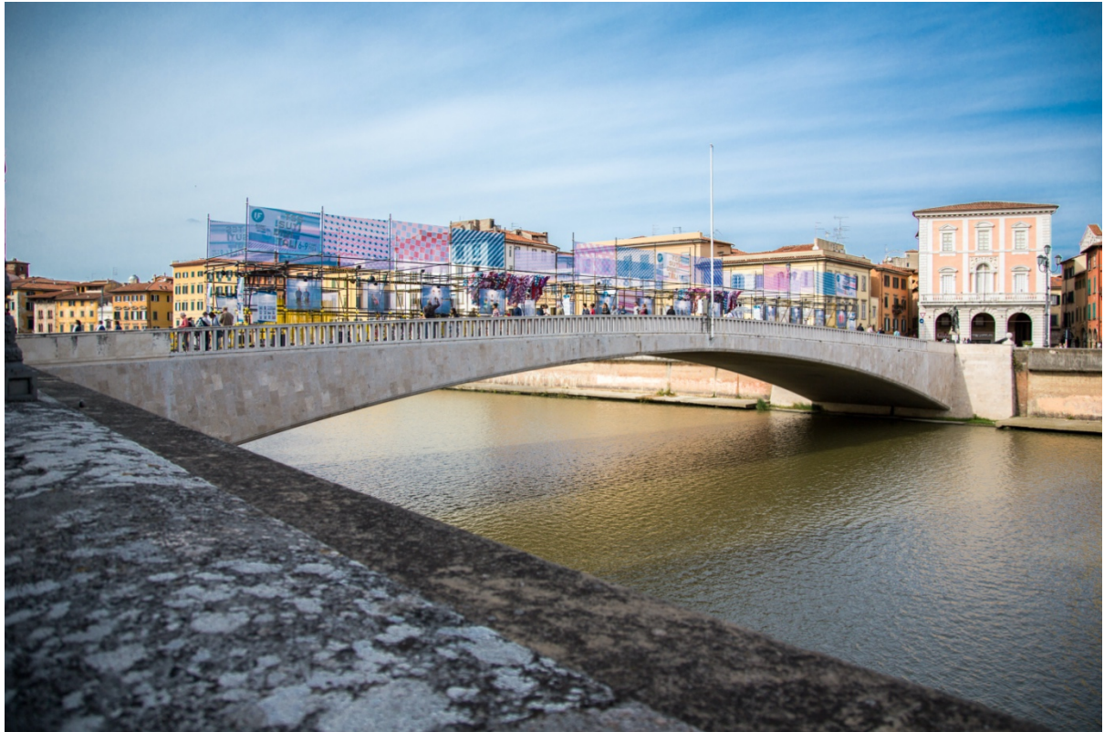
Figura 4 - Installazione "Ad Rem" sul Ponte di Mezzo - edizione 2016
