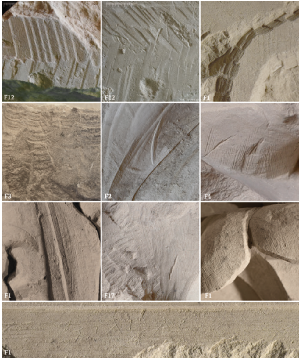
Fig. 6 Castro, Athenaion, tracce di lavorazione sui fregi a racemi: dall'alto accetta (F12), scalpello piatto (F1), scalpello a punta curva (F3), sgorbia (F2), raschietto o raspa (F1, F4, F17) e iscrizione incisa sulla parte non lavorata di F1
