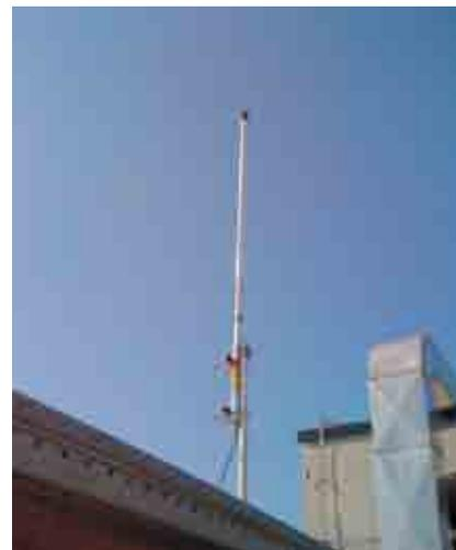
Fig. 2 L'antenna installata per l'acquisizione radio di segnali AIS
