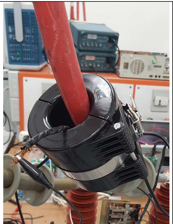
Figura 31 Accoppiatore induttivo montato sul conduttore MT in laboratorio
