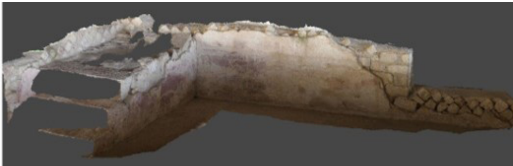
Fig. 9. Villa di Cottanello, restituzione fotogrammetrica di parete intonacata.
