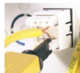
Figura 6. Connettore RJ45.
