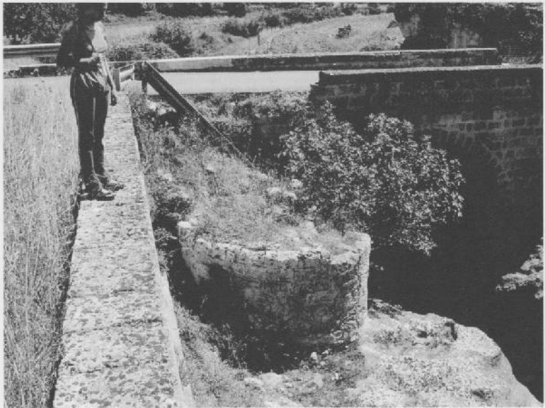
Figura 4 - Ingresso di un pozzo nei pressi di San Michele.
