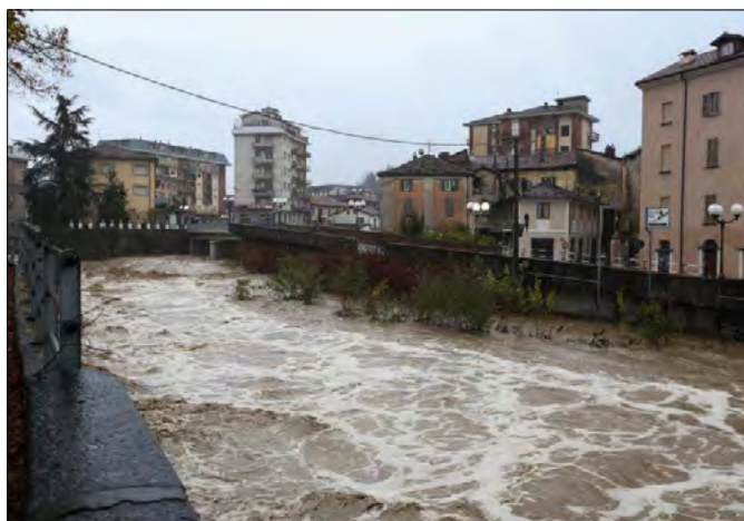
Figura 13. Evento alluvionale del 21-25 novembre 2016: in corrispondenza della sezione C1, le impetuose acque del T. Cevetta sono fortunatamente rimaste al di sotto anche degli argini naturali (RIF. WEB n. 2)
