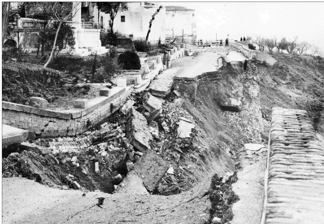
Figura 3. Craco. Frana del 17 gennaio 1965. Muro a sostegno della SS103 crollato a seguito della riattivazione della frana (Fonte: Archivio Storico Dipartimento Protezione Civile, Ministero LL. PP., Divisione 29, Matera C., Colobraro-Craco, B. 4. Craco - Zona movimento franoso. Foto sciolte. Craco, 17 gennaio 1965)
