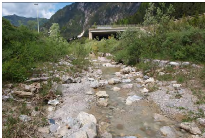
Fiume Fella, post operam, maggio 2011
