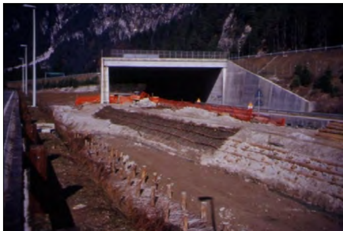
Fiume Fella, in opera, 1998
