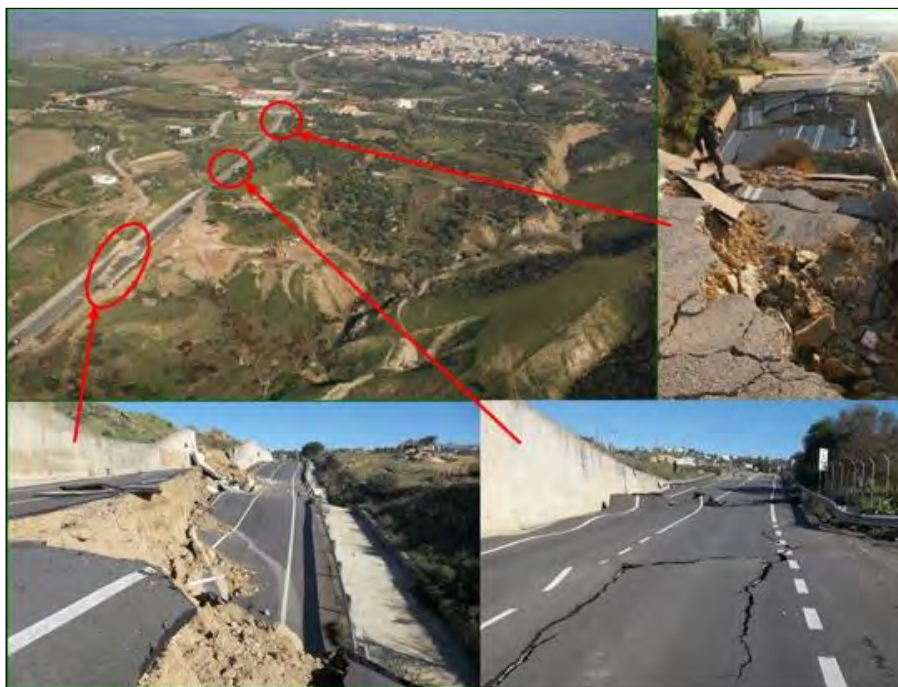
Figura 2. Foto aerea della frana e danni alla strada di collegamento dell'abitato di Montescaglioso con la strada statale di fondovalle
