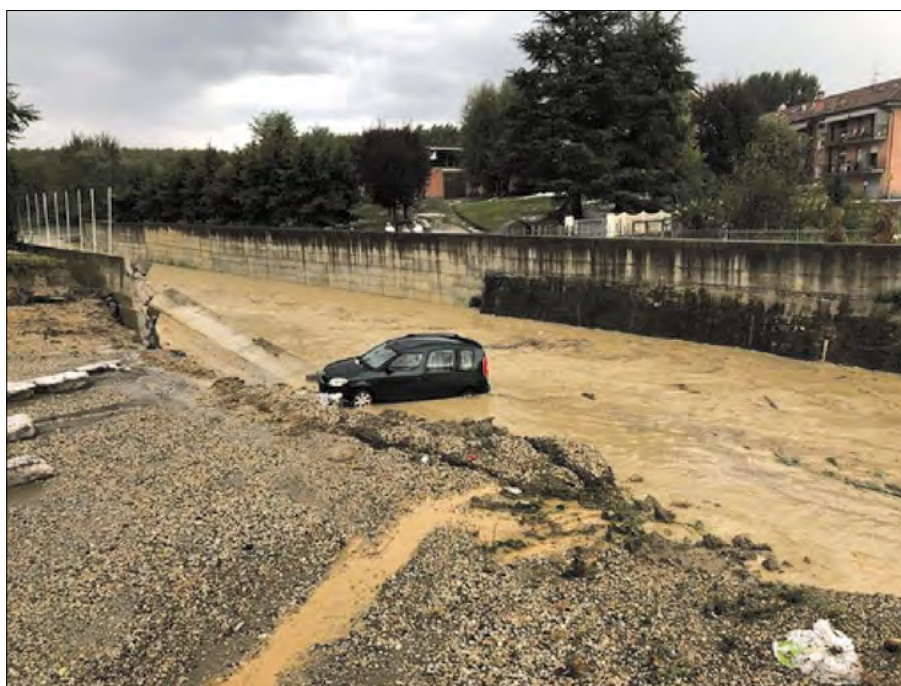
Figura 10. Il muro crollato appena a monte della sezione 1 a seguito dell'evento meteorologico del 5 settembre 2019 (Rif: WEB n. 4)
