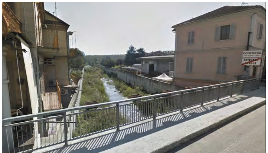
Figura 6. Ubicazione della sezione 1, immediatamente a monte del ponte sul T. Talloria di Sinio, posto al confine tra il comune di Grinzane Cavour e quello di Diano D'Alba: le case si trovano addossate al corso d'acqua
