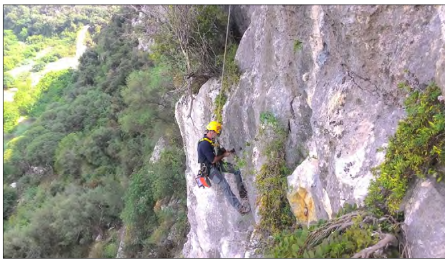
Figura 5. Fasi esecutive dei rilievi geostrutturali e geomeccanici
