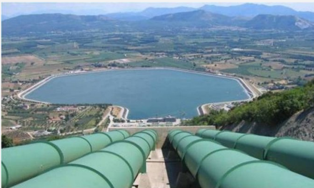
Presenzano (Caserta), vista da monte dell'invaso di valle
