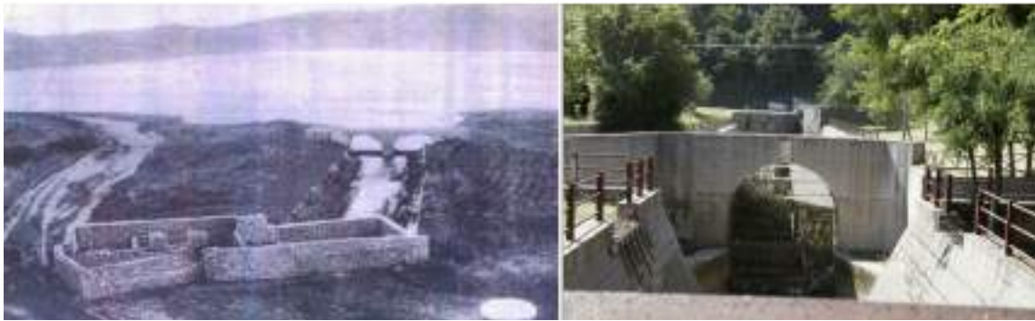
Foto 2 Opere a presidio dell'inghiottitoio della Piana del Dragone (primi '800) Canale d'ingresso all'Inghiottitoio carsico allo stato attuale
