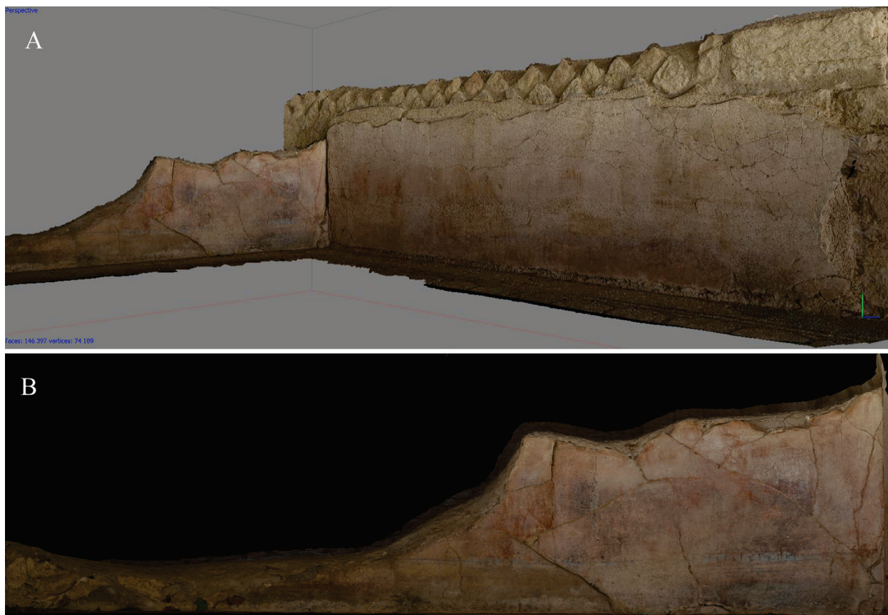
Fig. 2 - Intonaci dipinti dell'ambiente 9. a. Modello fotogrammetrico delle pareti sud e ovest; b. Ortofoto della parete sud in cui è visibile il listello azzurro da cui proviene il campione COT1 (elab. T. Leti Messina).
