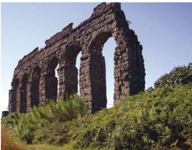
Fig. 3 - Arches of the Claudio Aqueduct at the Aqueducts Park in Rome (photo archive Egeria Centro Ricerche Sotterranee). Fig. 3 - Il Parco degli Acquedotti: le arcate dell'acquedotto Claudio, Roma (foto Archivio Egeria Centro Ricerche Sotterranee).
