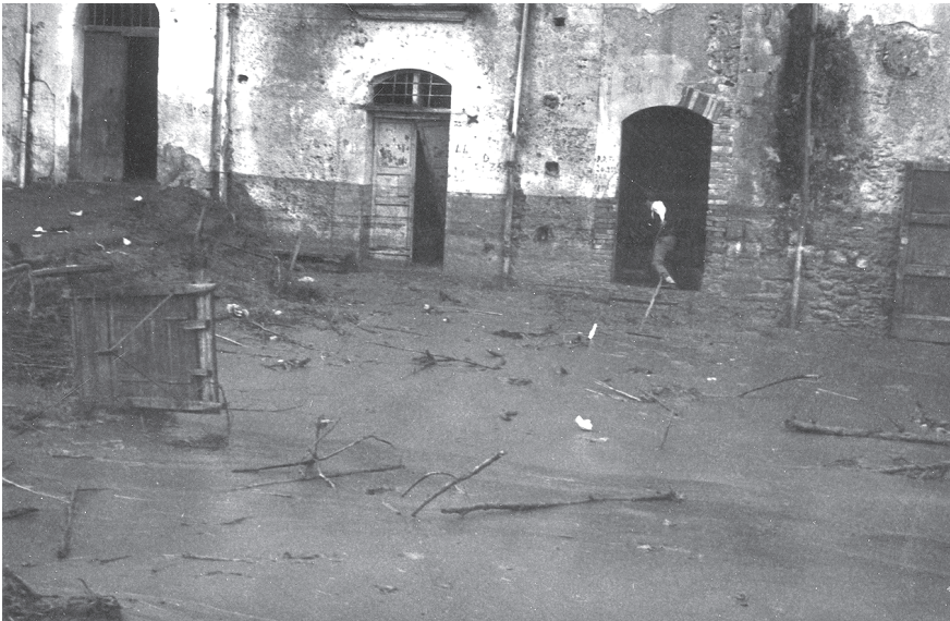
Fig. 16 – Cosenza, 24 novembre 1959: effetti della piena del Crati in via Lungo Crati n.139/141 (S. 513e)
