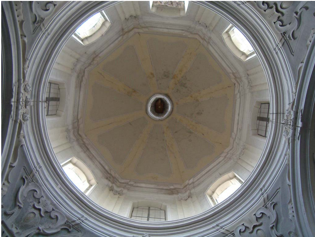
Figura 9. Vista dell'intradosso della cupola e del tamburo.
