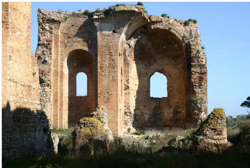
Figura 19. Resti della chiesa di Santa Maria della Roccella (interno).
