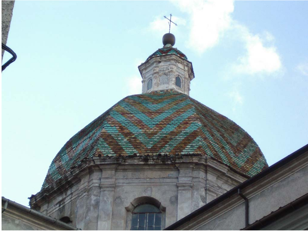
Figura 8. Vista esterna della cupola e del tamburo.
