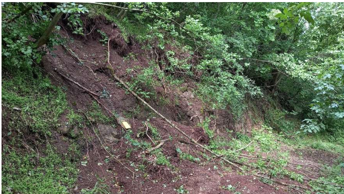
Fig.3.2.21: earth flow all'interno della zona C.
