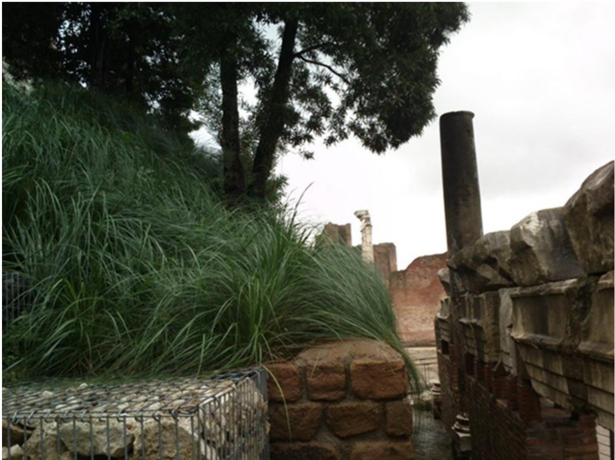
*Fig.22 Messa a dimora di "prati armati" installati a consolidare in modo naturale pendii di terre instabili rimanenza degli scavi archeologici dell'inizio del XX secolo, messa a dimora di specie botaniche provenienti dalla Mauritania con apparati radicali sottilissimi che avvolgono i terreni inconsistenti rendendoli maggiormente compatti. - Credits: Archivio autrice.*
