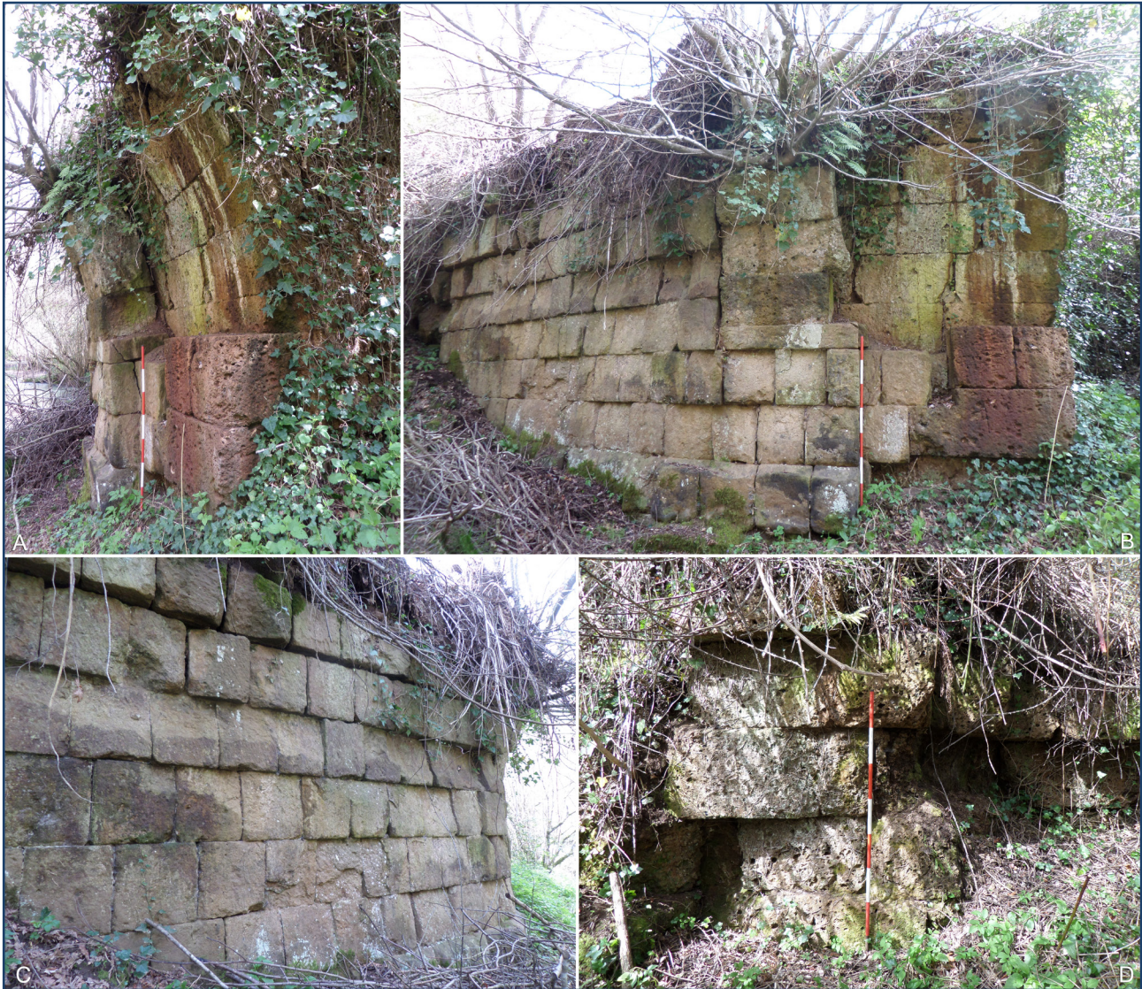
Fig. 14: Ponte lungo il Fosso di Valle Canale: A, il pilone e la spalla sul lato orientale del corso d'acqua; B-C, muro controterra in blocchi di peperino; D, resti del pilone occidentale.
