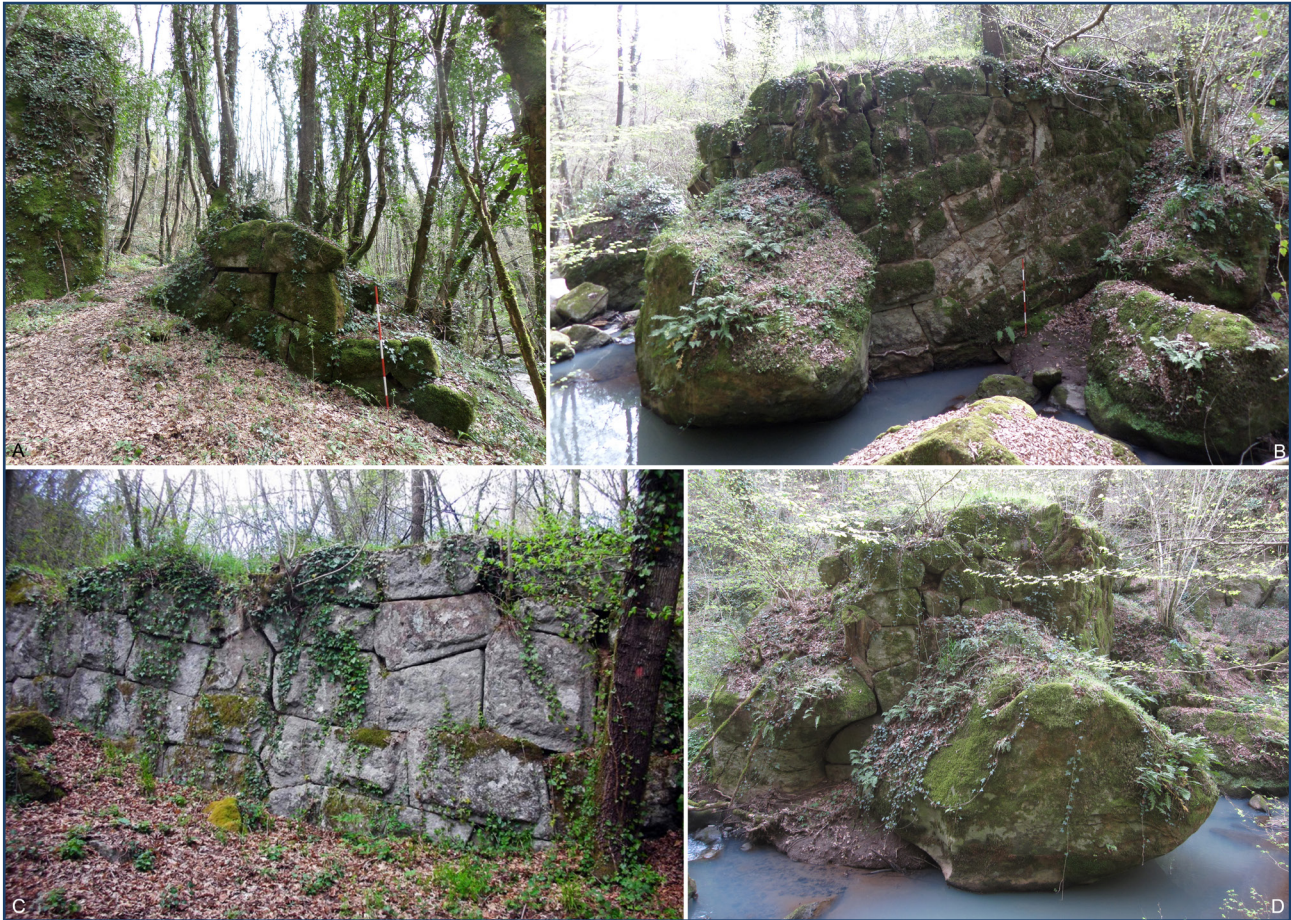
Fig. 12: Sbarramento lungo il Fosso di Valle Canale: A, lato a monte, porzione orientale; B, lato a monte, porzione occidentale; C, lato a valle, porzione occidentale (da https://mapio.net/pic/p-46109455/ ); D, terminazione est della porzione occidentale.
