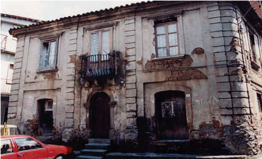
Fig. 6 Calabria, "Palazzotto". Credits: R. Chimirri
