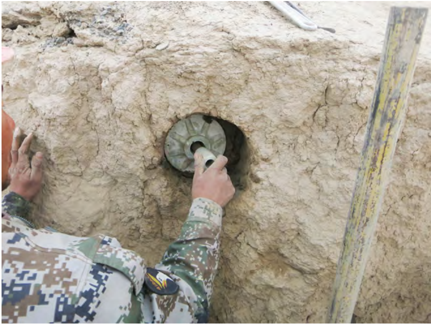
Fig. 3e Pad installation
