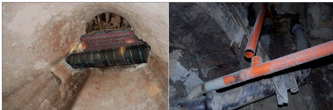
Figura 3 – Evidenze di sottoservizi, dall'interno di cavità artificiali al di sotto del centro abitato di Gravina in Puglia.
