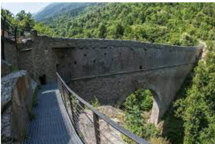
Fig. 25 - Pont d'Ael presso Aosta. Il camminamento interno (sopra) e esterno (sotto)
