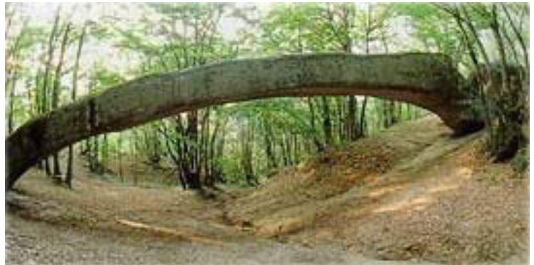
Fig. 23 - Il ponte di Pavullo
