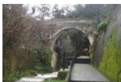
Fig. 15 Il ponte di Paola
