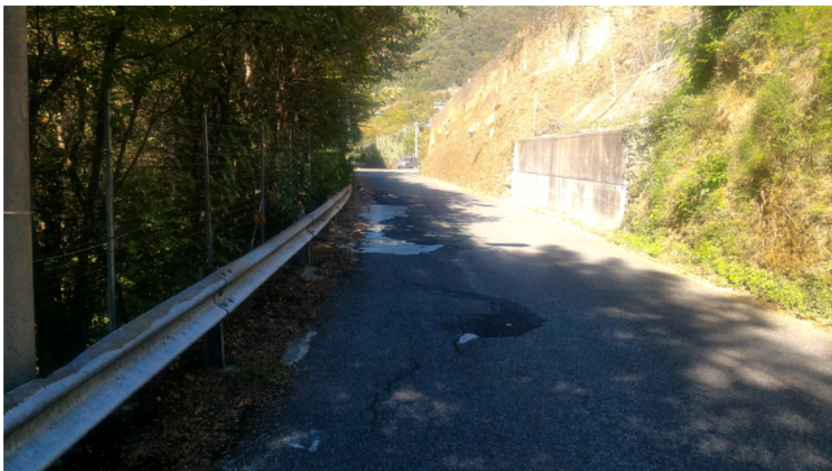
Figura 21: strada adiacente al cimitero, la fotografia rappresenta lo stato dei luoghi in data 3 ottobre 2018.
