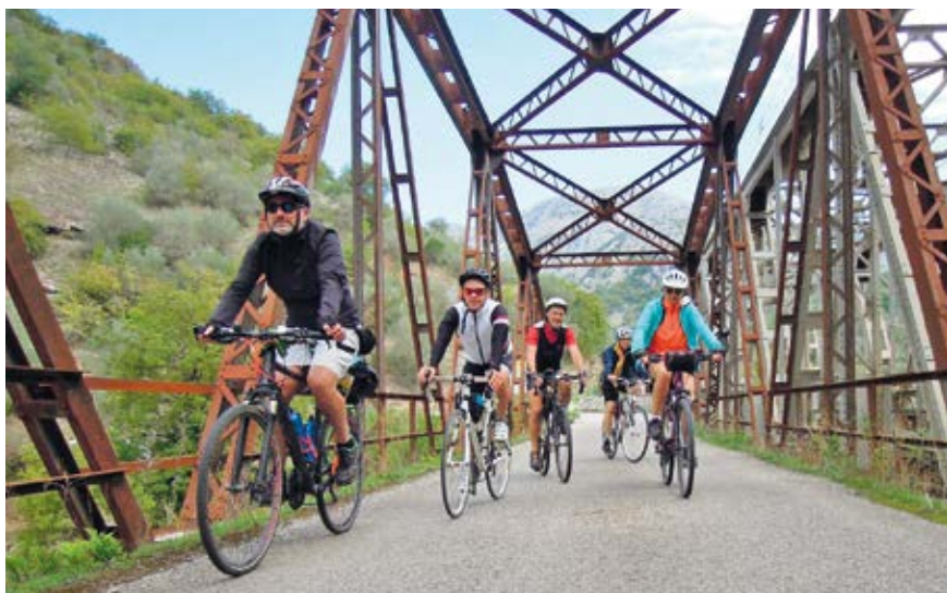
Figura 40. Tra Campania e Basilicata, attraversamento di un vecchio ponte ferroviario. Foto di Antonio Bergamino
