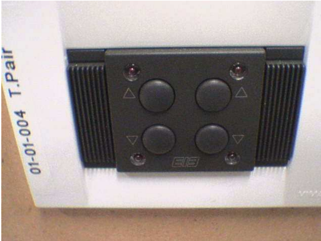
Figura 8.6: Pulsantiera Konnex a 4 canali.
