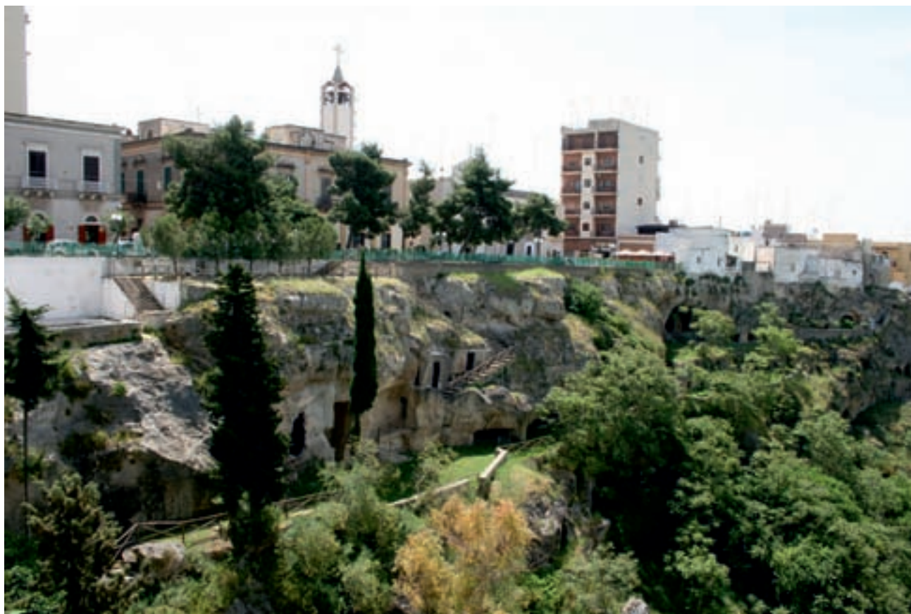
Fig. 2 - Diffusi vuoti sotterranei di origine antropica al di sotto delle attuali città possono essere all'origine di pericoli per l'ambiente urbano (Massafra). - The many underground voids excavated by men in different epochs, nowadays located below the present towns, may be at the origin of danger to the urban area (Massafra).
