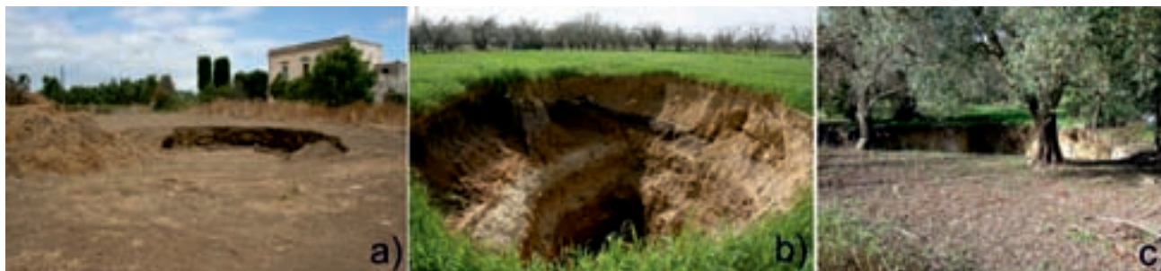
Fig. 7 - Recenti eventi di sprofondamenti a Cutrofiano, a causa della presenza di cave sotterranee in calcarenite: a) 15 luglio 2008; b) Marzo 2010; c) Ottobre 2010 (foto G. Quarta).
