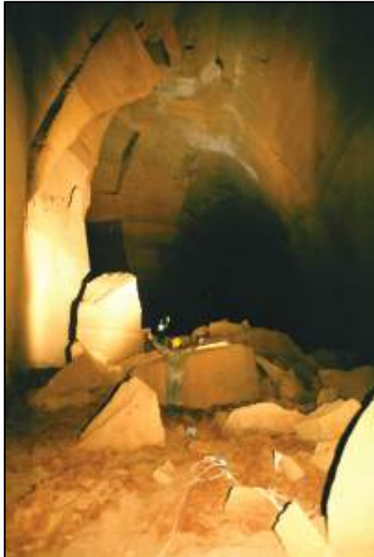
Figura 3.1: Cavità in tufo con crolli Fonte: Foto di Antonino Barba
