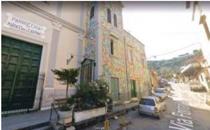
Figura 8.5: La facciata colorata della Parrocchia spicca nel quartiere, mentre l'ingresso del Cimitero è ben poco segnalato
