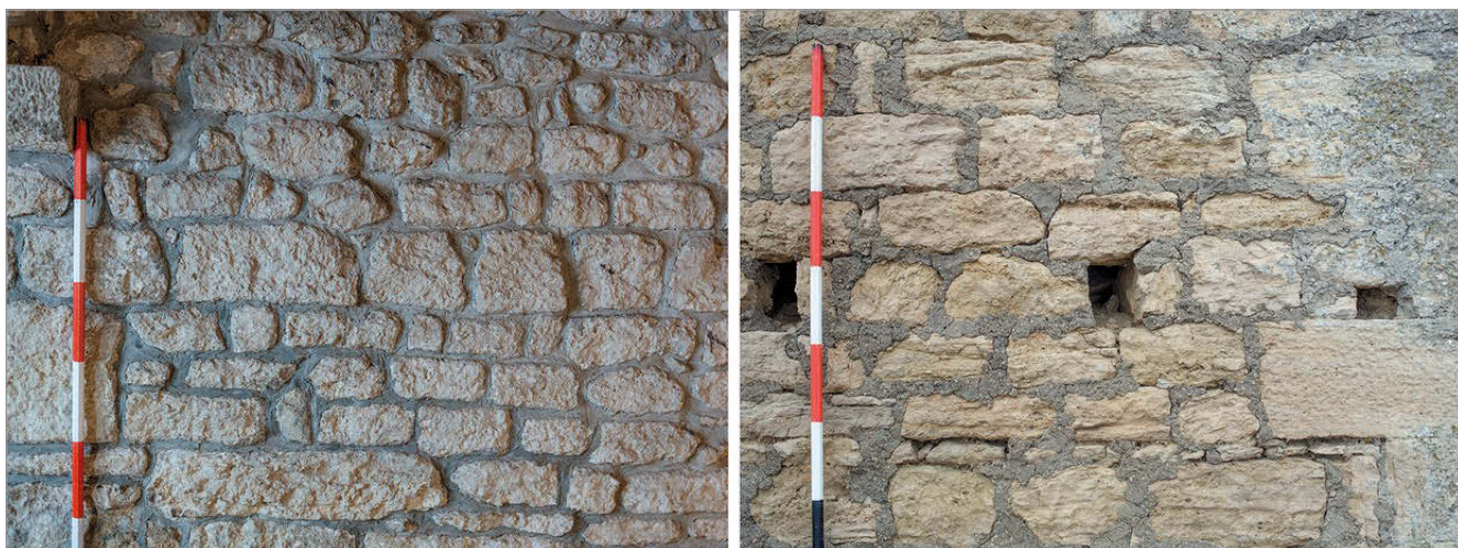
fig. 15 – Confronto tra la tecnica muraria della Seconda Torre (sinistra) e della Terza Torre (destra).
