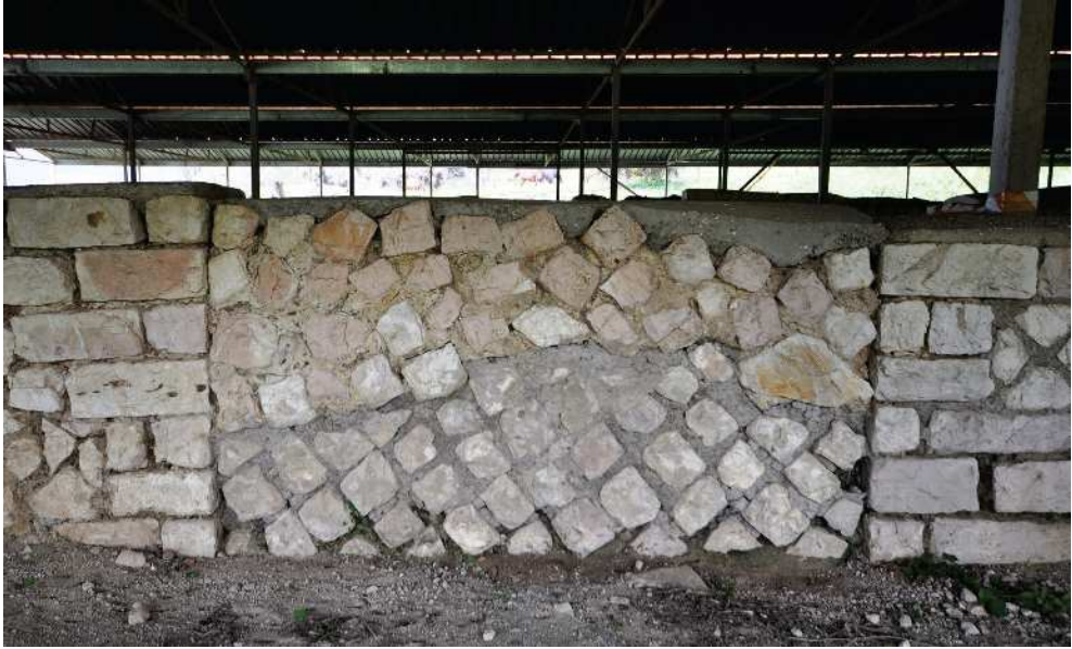
Fig. 5: Villa di Cottanello: tamponatura tra gli ambienti 14 e 15 da est; la porzione originaria (in alto) è stata integrata dal restauro fino alla quota di calpestio della fase II (da GASPARINI, RESTAINO 2017, p. 56, fig. 19).
