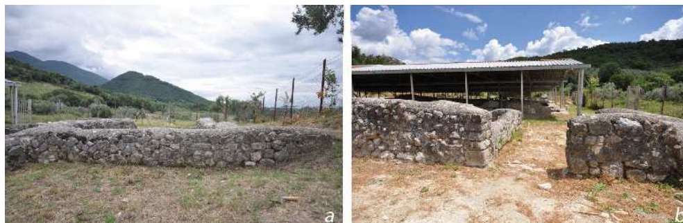
Fig. 8: Villa di Cottanello, strutture del settore occidentale: a. muro sud dell'ambiente 33; b. muro est dell'ambiente 32 (da GASPARINI, RESTAINO 2017, p. 59, fig. 23).
