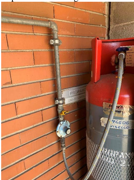
Figura 3. Bombola propano con regolatore pressione con tappo a vite di sicurezza
