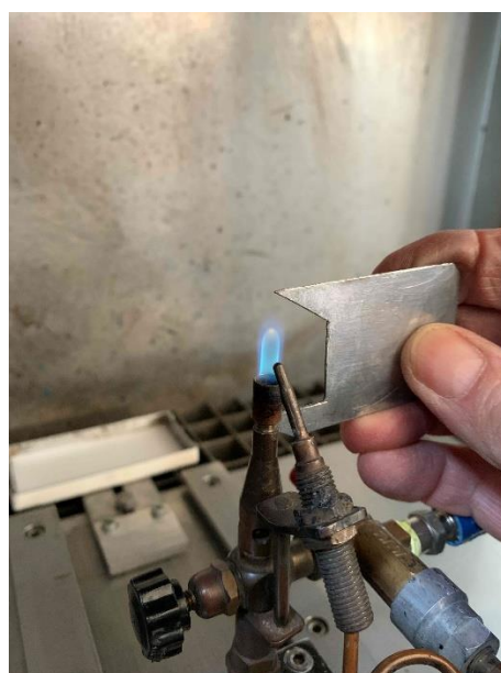
Figura 7. Altezza fiamma non conforme con pressione a 66 mbar
