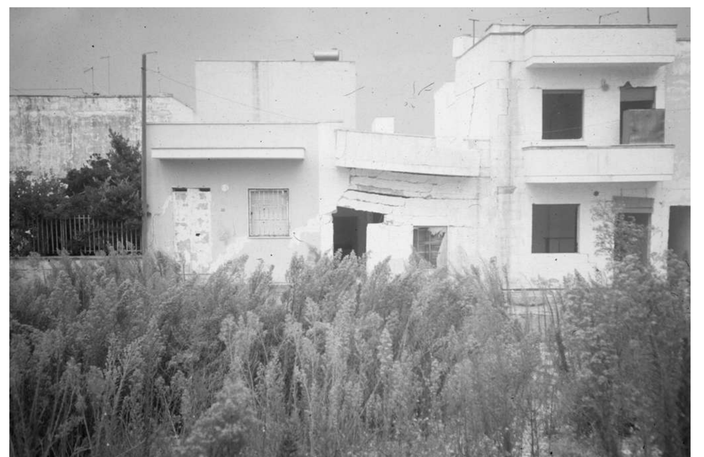
Edifici crollati a Casalabate in conseguenza dell'evento di subsidenza carsica del 1993.
