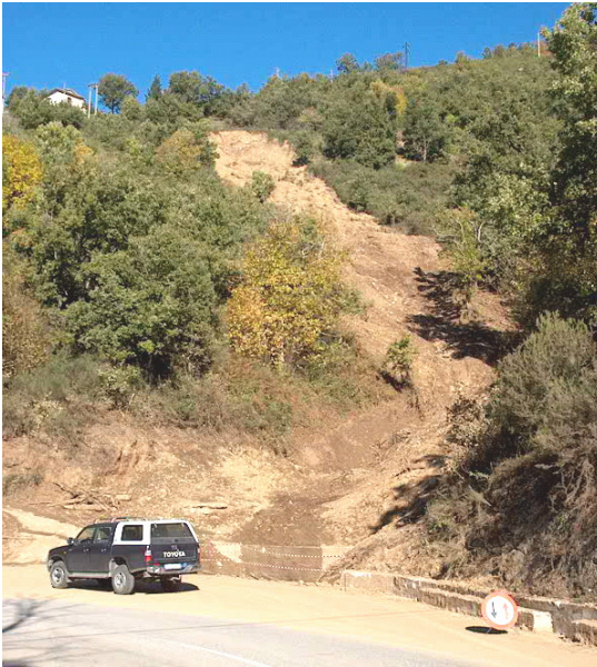
Fig. 7 – Frana lungo la strada Parenti-Rogliano in località Pianetto Zanco (CS) (foto: O. Petrucci).
