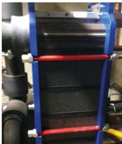
Figura 5. Scambiatore di calore primario realizzato in titanio.
