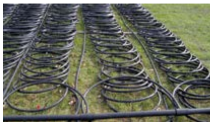
Figura 7. Sonde geotermiche orizzontali a spirale durante la fase di posa.
